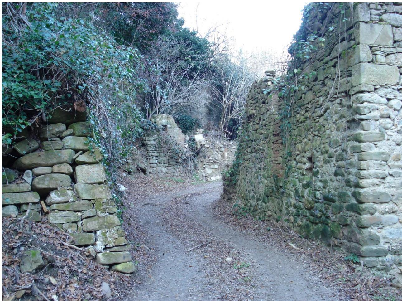
Fig. 4 - L'imponente muro della paratoia, alto più di 3 metri, ottimamente conservato.
